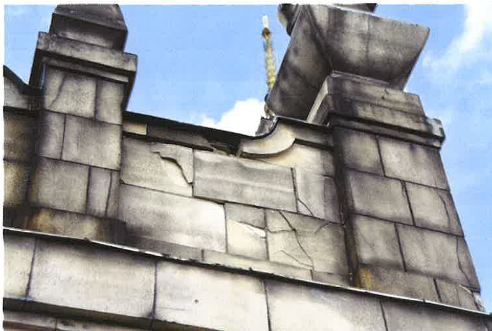
Pęknięcia biegnące przez fragment okładziny muru narożnego Attyki. Stan obecny.
