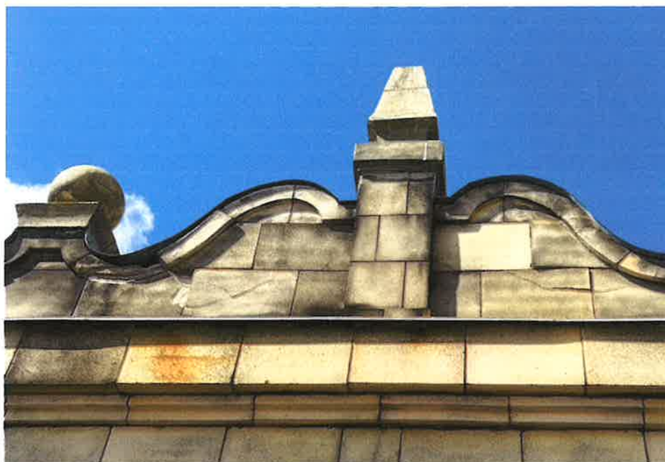
Pęknięcia biegnące przez fragment okładziny muru narożnego Attyki. Stan obecny.
