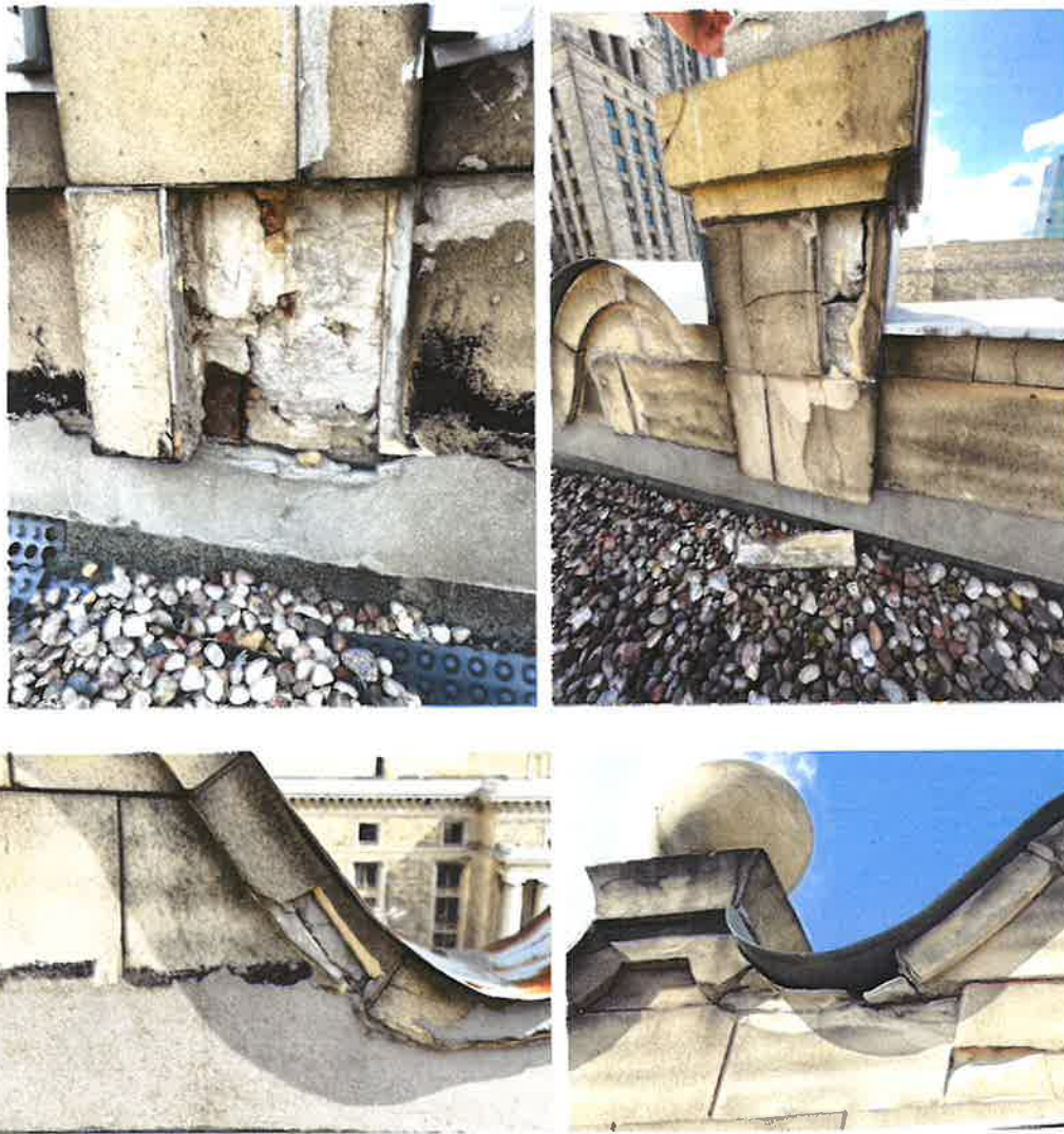
Przykłady typowych uszkodzeń i ubytków materiału ceramicznego na ścianach attyk.
