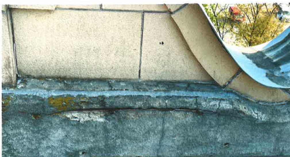
Widoczna destrukcja betonu w miejscach korozji stalowego zbrojenia. Stan obecny. Październik 2023 r.
